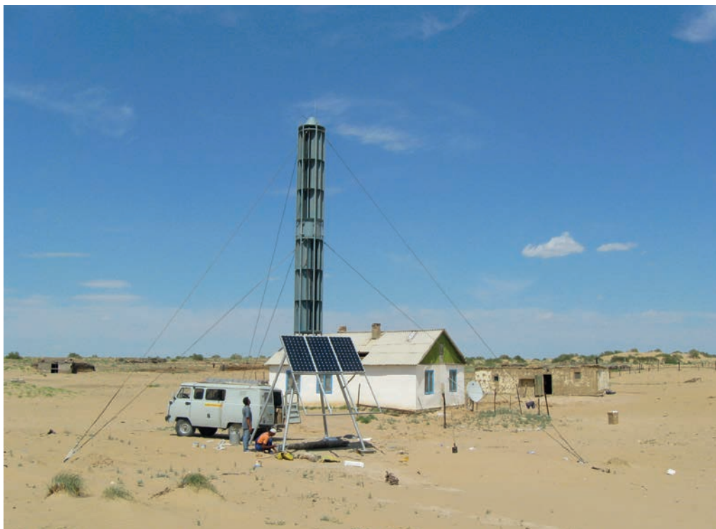
1996 год. Монтаж солнечно-ветровой установки для питания объекта поселка Кожаказган, Кызылординская область. Заказчик – АО «Казактелеком»
