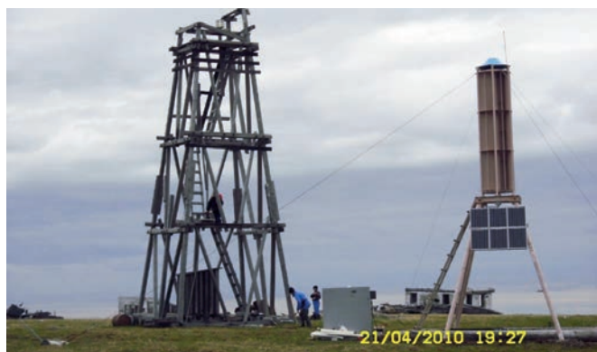
Маяк на мысе Челюскина, Северный Ледовитый океан. Техническое обслуживание КЭС ВРТЬ-2 Болотова, совмещенная с фотоэлектрическими панелями для светомаячной системы России
