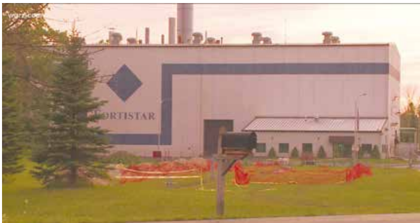
Газовая станция «Фортистар» в Северной Танаваде, штат Нью-Йорк
