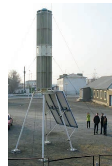
2006 год, КЭС ВРТБ-2,6 на объекте АО «Казакхтелеком», поселок Ажар, одновременно обеспечивает питание электронного оборудования школы
