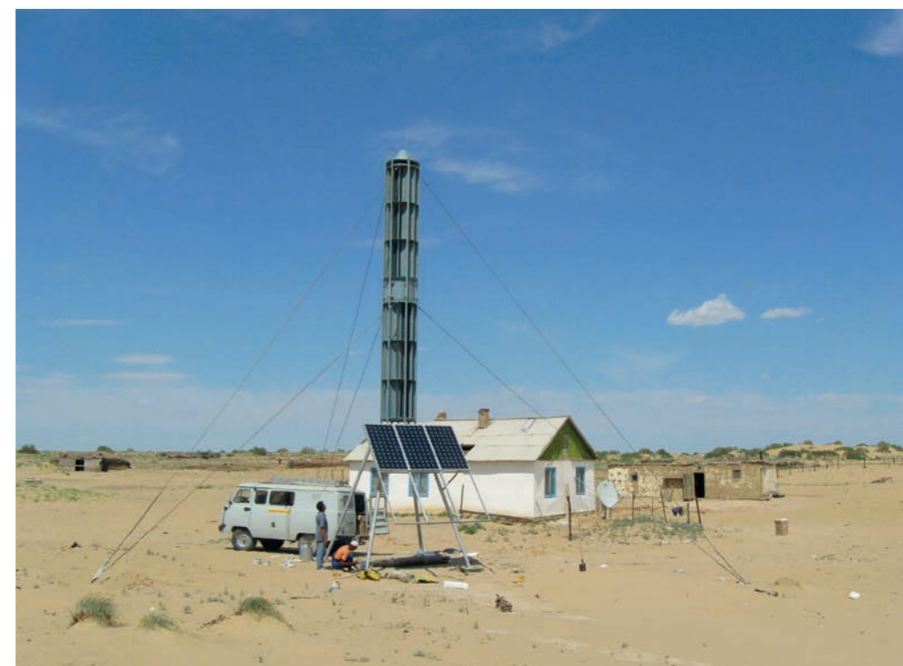
1996 год. Монтаж солнечно-ветровой установки для питания объекта поселка Кожаказган, Кызылординская область. Заказчик – АО «Казакхтелеком»
