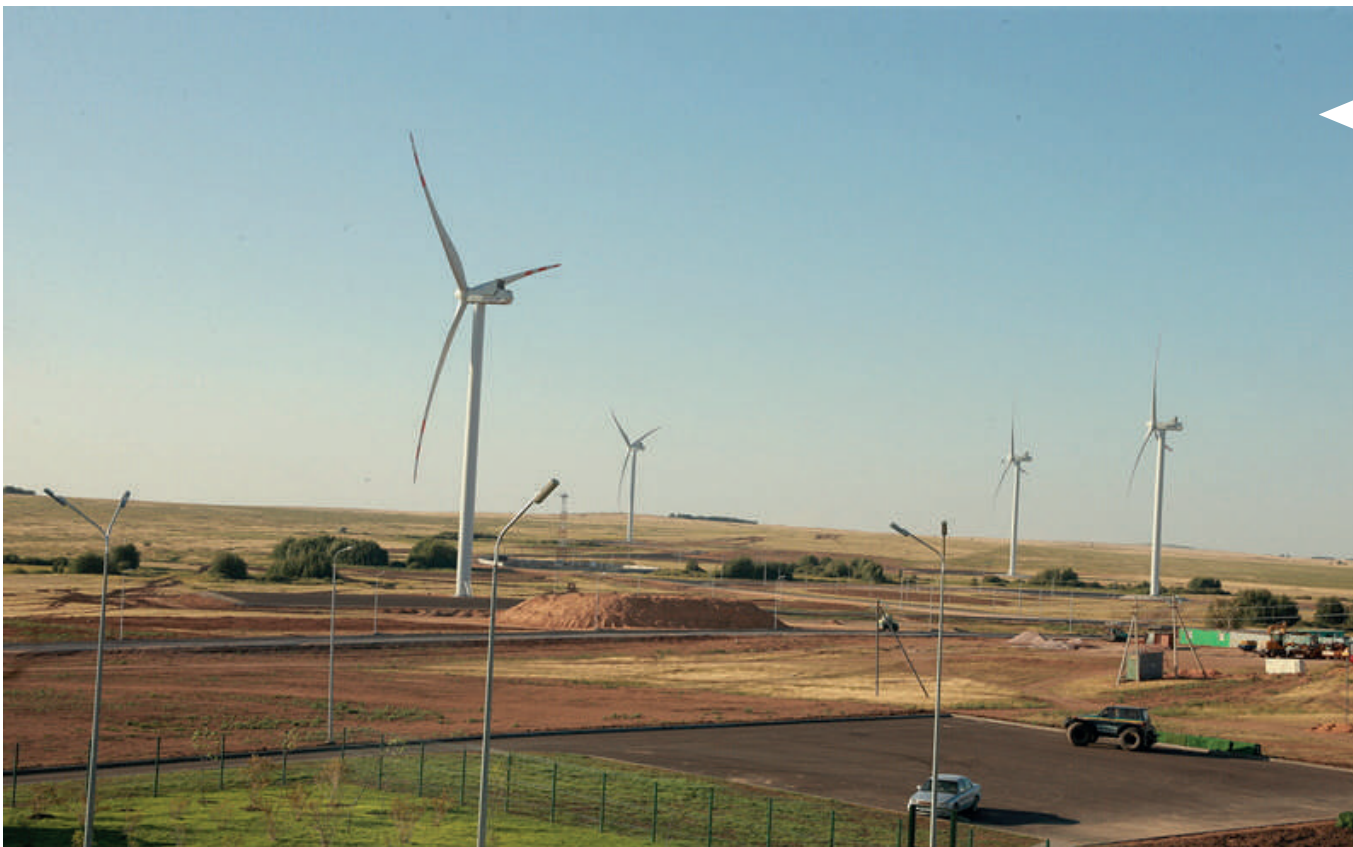
Ветровая электростанция «Астана Экро-2017» в поселке Костомар Акмолинской области
