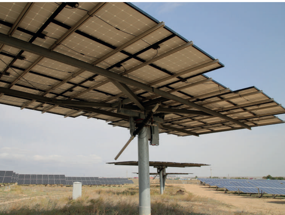
ТОО Samruk Green Energy СЭС мощностью 2 МВт
