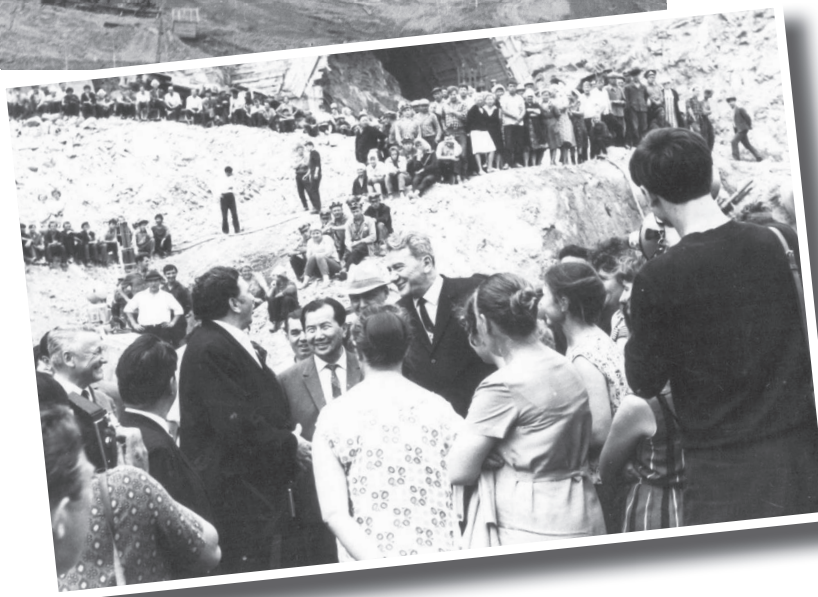
Встреча Д. А. Кунаева со строителями ГЭС
