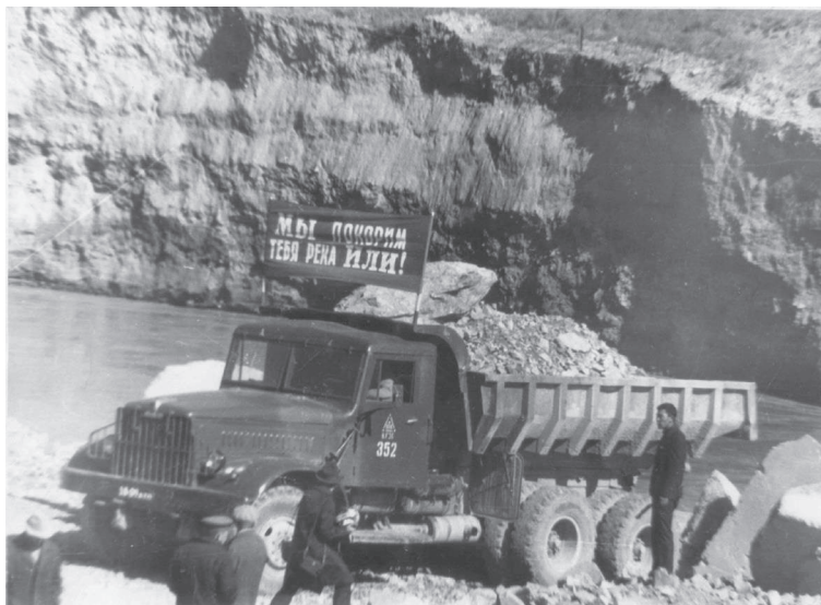
Перекрытие реки Или
