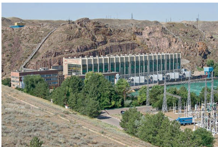
Капшагайская ГЭС. Вид со стороны русловой плотины
